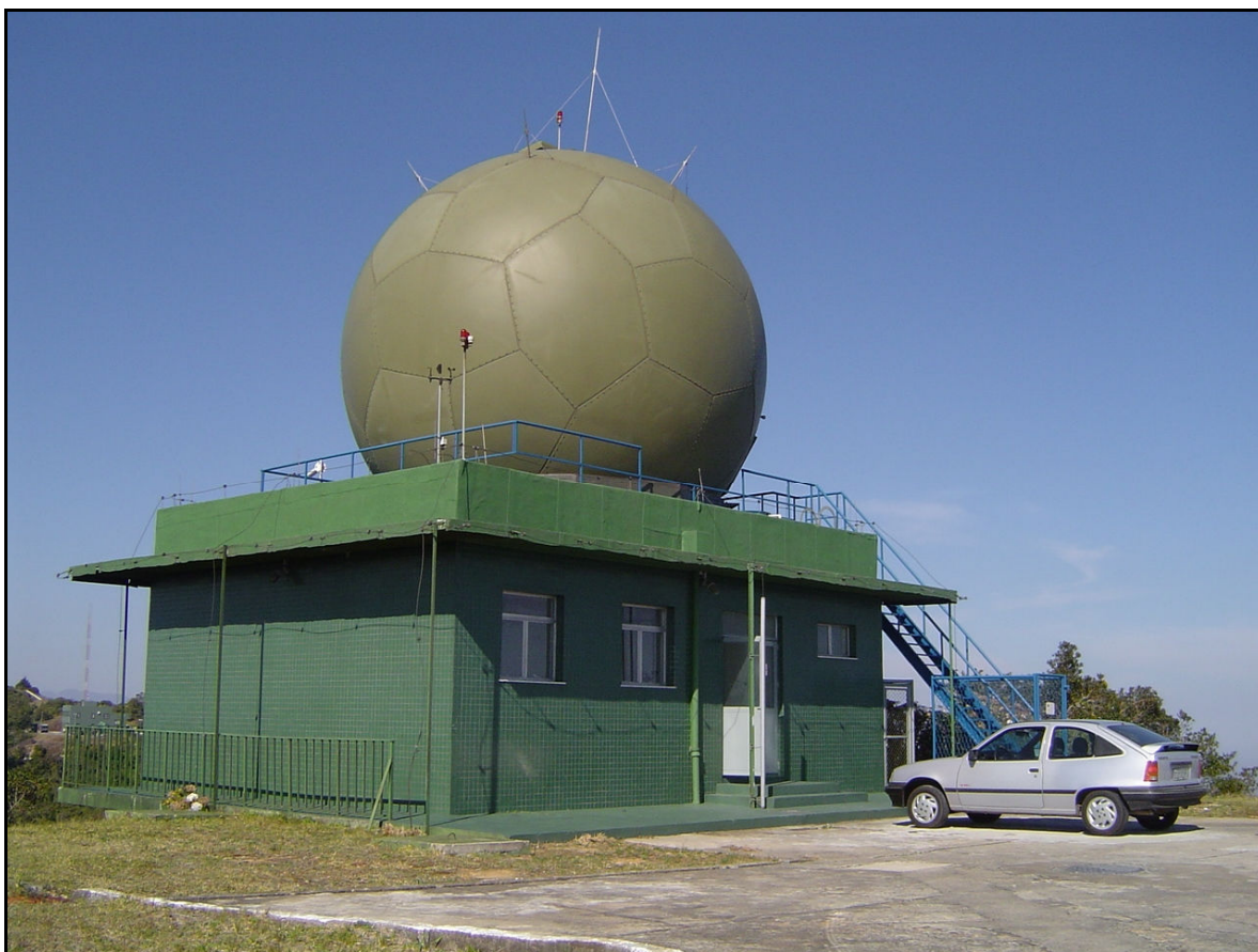
Figura 2: Radar Meteorológico Pico do Couto, Petrópolis – RJ. Aparelho do tipo Doppler.
