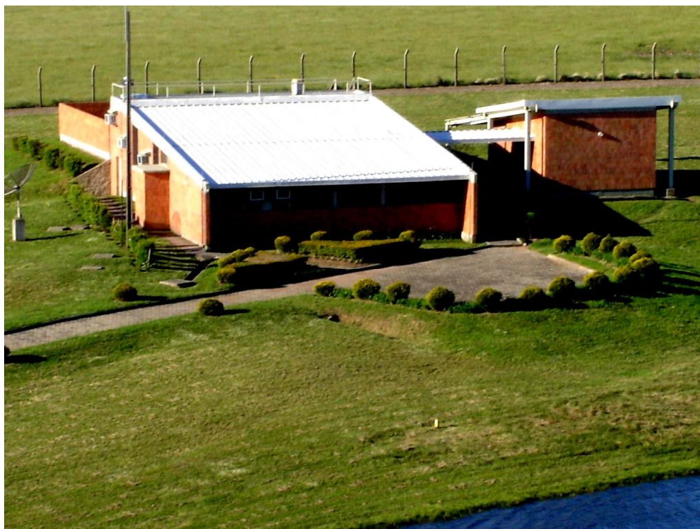
Figura 7.1 – Prédio 5 do Observatório Espacial do Sul – OES/CRS/INPE – MCT, em São Martinho da Serra, RS.
