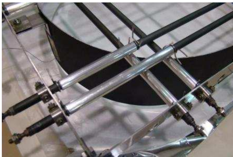
Figura 15 - Detalhe da fixação dos CAL-RODs no suporte.
