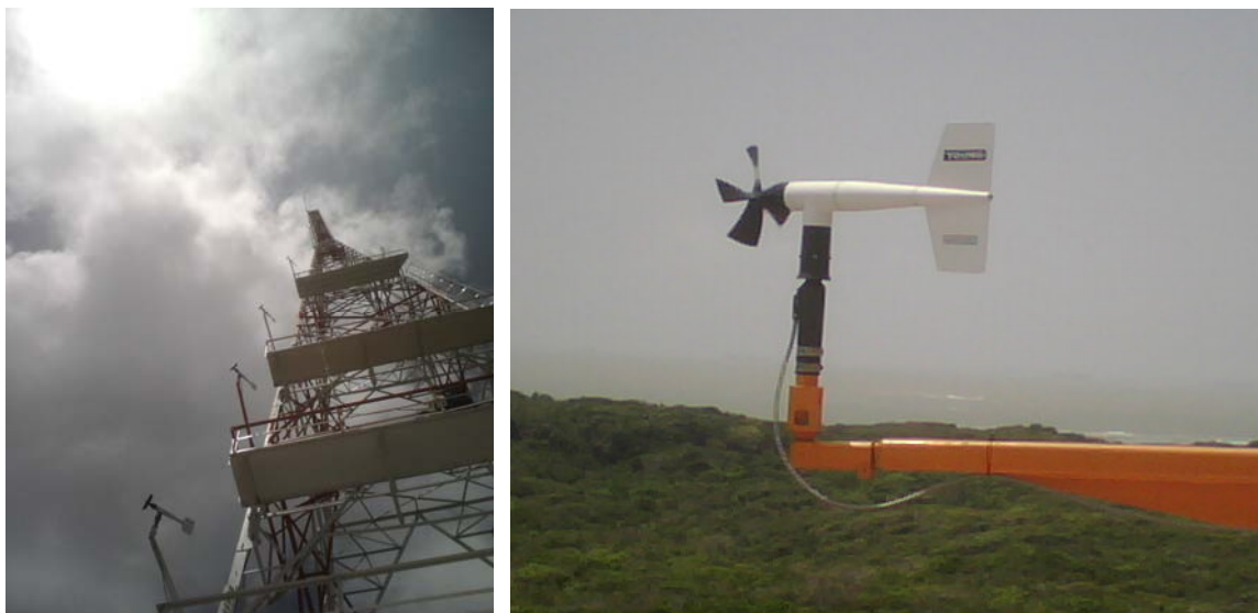
Figura 3.2 – Torre Anemométrica e sensores de velocidade do Centro de Lançamento de Alcântara (CLA)
