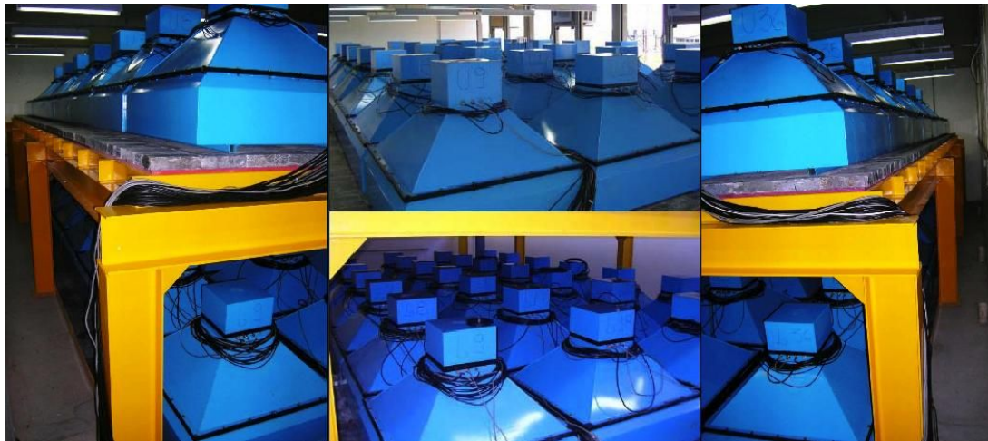
FIGURA 36: Foto do TCM instalado no OES em dezembro de 2005.
