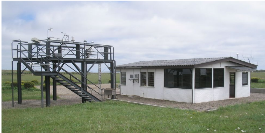
Fig. 4.1 – Plataforma com equipamentos instalados e prédio 1 no Observatório Espacial do Sul, em São Martinho da Serra, RS.
