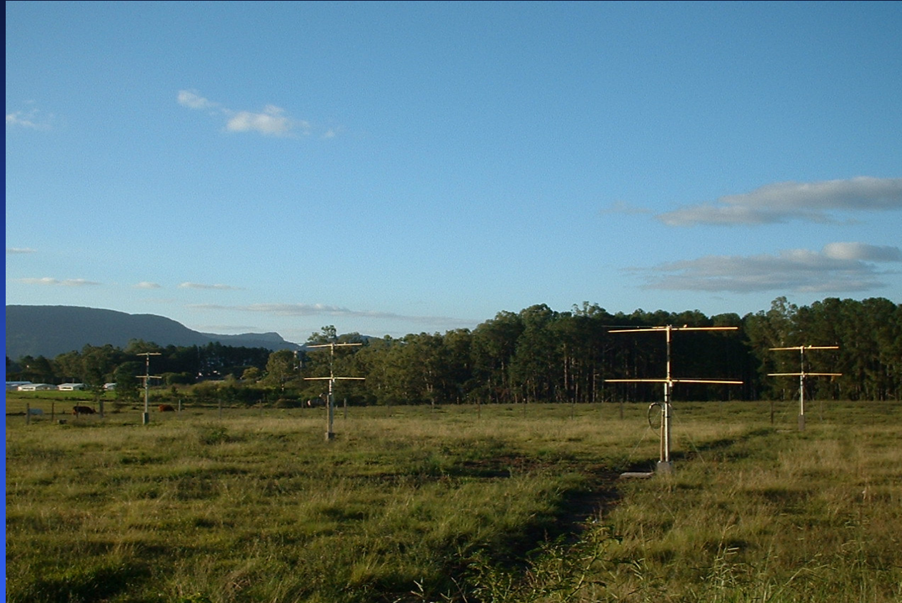
Fig. 2 – Antenas Receptoras, do tipo Yagi de 2 elementos, do Sistema SKiYMET do CRSPE/INPE – MCT, instalado em Santa Maria, RS.
