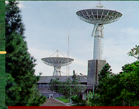
Estação recepção Cuiabá/MT
