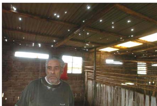
Figura 4: Galpão em São Sepé danificado pelo granizo nos dias 11 de setembro e 13 de outubro. Foto: Lauro Alves, Zero Hora
