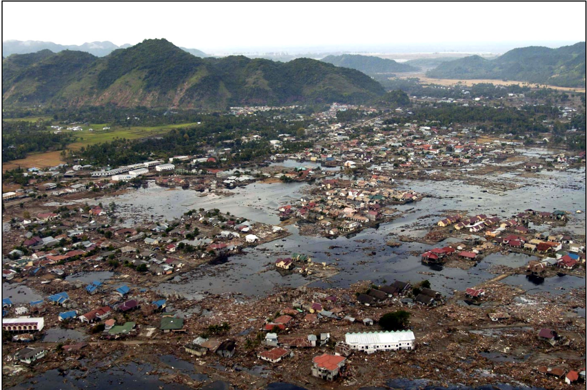
Figura 3 – Destruição provocada pelo tsunami de 2004 em Sumatra, Indonésia. Fonte: www.wikipedia.org
