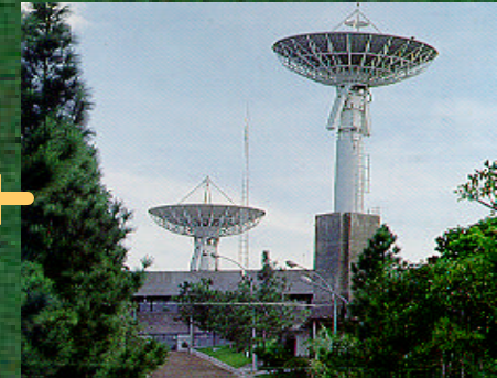
Estação recepção Cuiabá/MT Ou site MODIS da NAS
