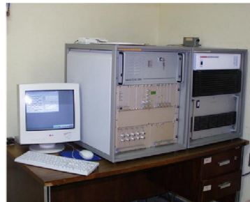
Equipamento transmissor e receptor do SKIYMET
