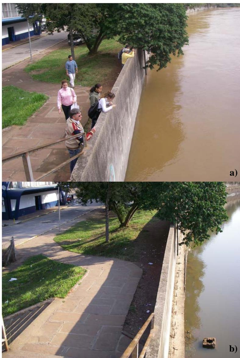
Figura 6.66- Dique separando a rodoviária de Leopoldo à esquerda e o rio dos Sinos à direita. a) Comparação dos dias 08 de maio (cota do rio com 5,55 m); e b) 22 de maio (cota do rio com 0,80 m), coordenadas geográficas: 29°45'35,42"S e 51°08'53,61"O, Datum: WGS84.
