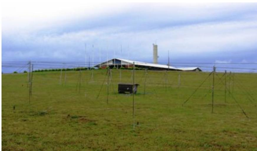
**Figura 4.8:** Antenas dipolos 4 x 4 instalados e em operação no Observatório Espacial do Sul – OES/CRS/CIE/INPE – MCT em São Martinho da Serra, RS.
